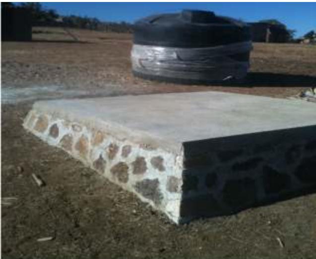
Construcción de bases para cisterna con capacidad de 5,000 litros en las comunidades de: Jalisco, El Limón, Tierra Blanca, Los Espejos, La Laguna, Bajío del Carrizal, El Menudo, La Nariz, Agua Zarca, La Manga, La Codorniz, Metatiza, Tierra Colorada, Los Encinos y Las Latas, esto con recurso del ramo 20 y como dependencia normativa de la Comisión Estatal del Agua.
