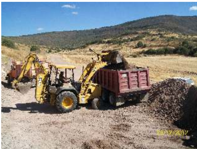
Rehabilitación de camino de San Juan de los lirios a cruce del ojo de Agua en la zona mestiza, con un monto de $60,000.00.
