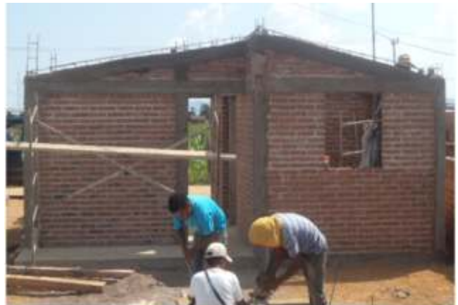
Construcción de 5 unidades básicas de vivienda (casas) en la comunidad de San Andrés Cohamiata, con recurso federal y municipal, en su primera etapa.
