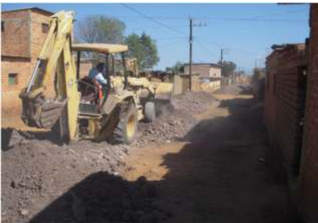
Rehabilitación de calles en la comunidad de San Andrés Cohamiata con maquinaria y recurso del H. Ayuntamiento.
