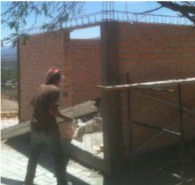
Construcción de Bodega en el Panteón Municipal.
