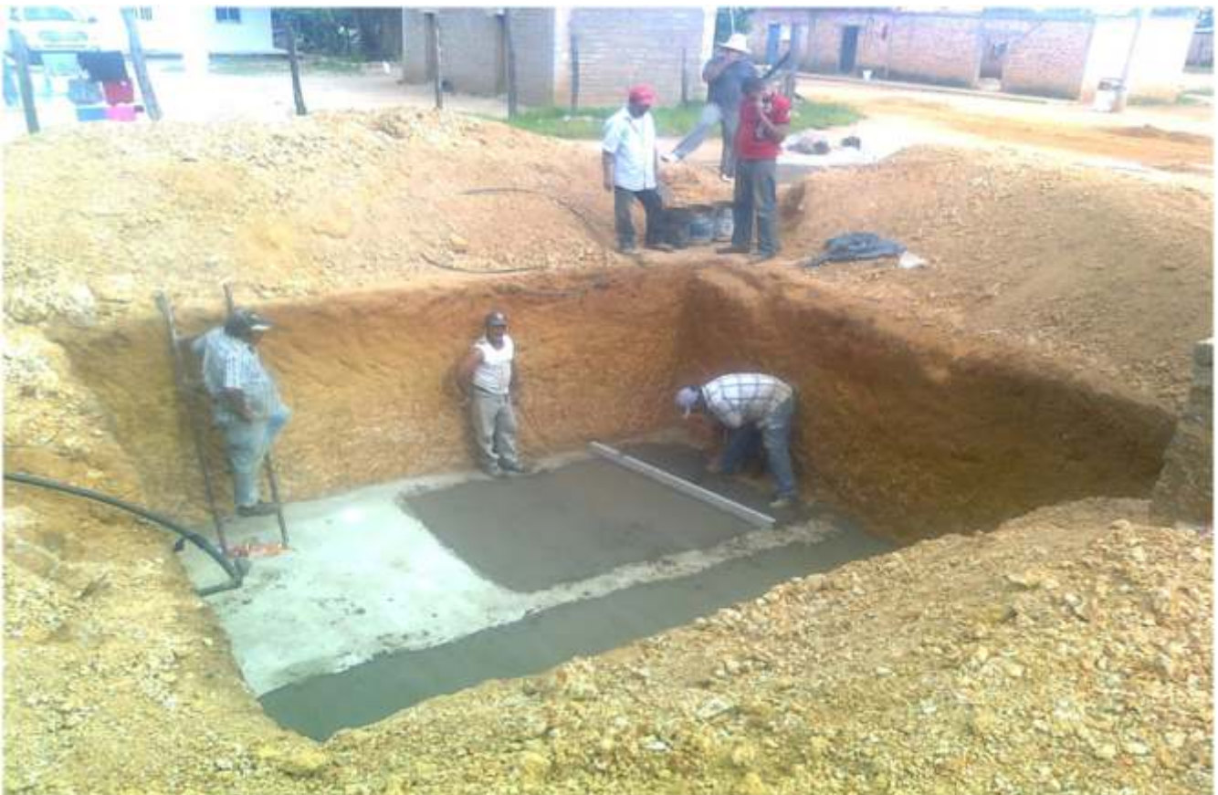
Elaboración de bases para cisternas.
