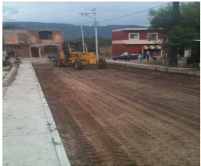
Pavimentación de la calle Fray Margil de Jesús en el fraccionamiento Loma de los Frailes de esta cabecera municipal.
